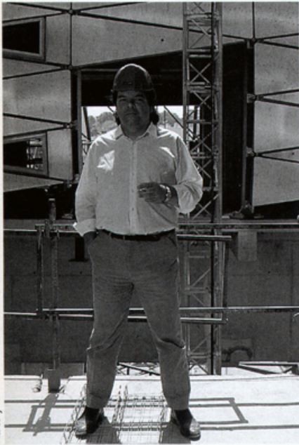
William A. hat seine Baustelle fest im Griff...
